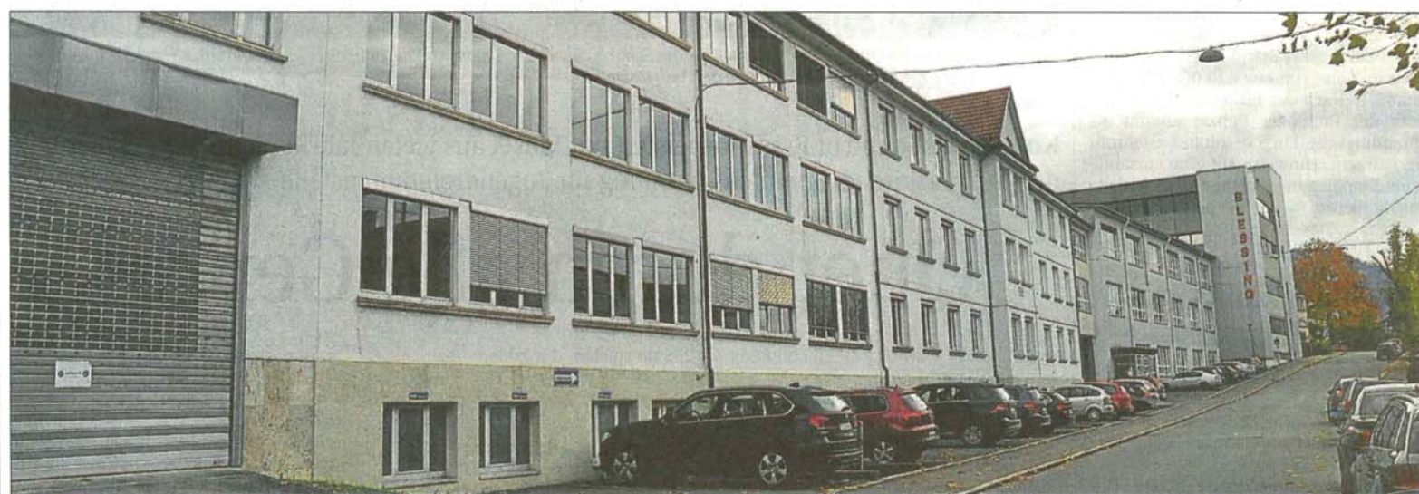
Die Pfullinger Kaiserstraße wird vom Blessing-Firmengebäude geprägt. Dieser Teil, den die Robert Bosch GmbH gemietet hat, bleibt erhalten. Das Grundstück gegenüber soll bebaut werden.
