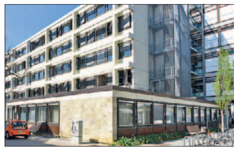
Das Rathaus, hier am Oskar-Kalbfell-Platz, ist sanierungsbedürftig. ARCHIV-FOTO: KUS
