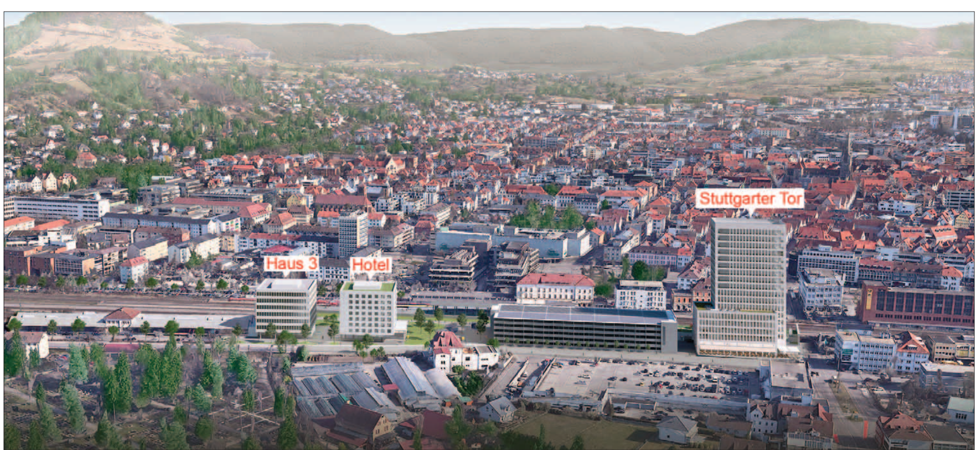
Das Hochhaus »Stuttgarter Tor« ist namensgebend fürs künftige Quartier. Das Hotel ist im Bau, Haus 3 in der Planung.
