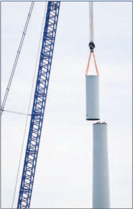
Aufsichten der Stahlsegmente.
