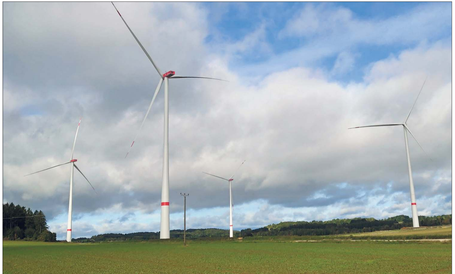
Die vier Anlagen links und rechts der L 230 gehen nach und nach ans Netz.
