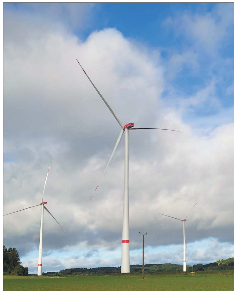
Der Windpark Magolsheim ging offiziell in Betrieb.
